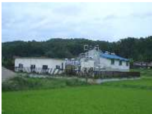
東禅寺浄水場
