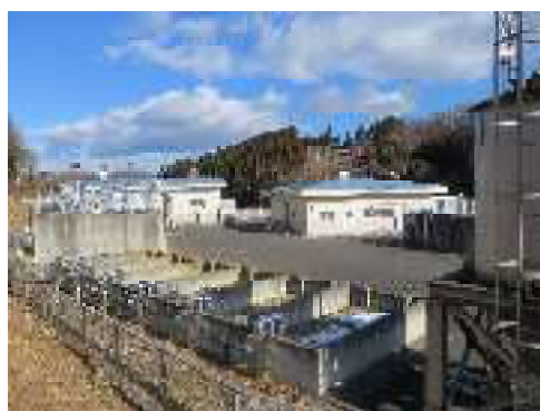
平田石浄水場
