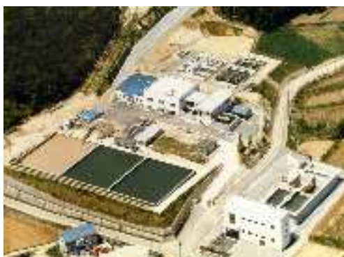
立石山浄水場
