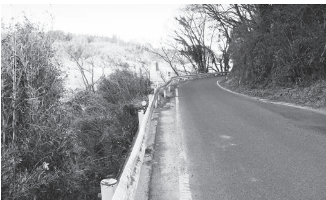
二本松・金屋線（北大沢地内）
