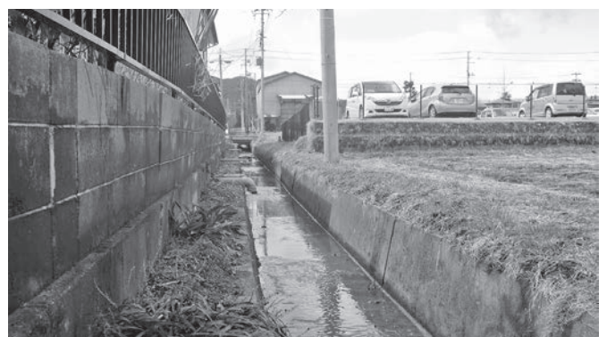
浸水被害の防止を（えぼか南側水路） ファシリティマネジメント…公共施設等を立て替えるのではなくニーズに合わせた改修等により長持ちさせ、経費も総合的に節約する方法。
