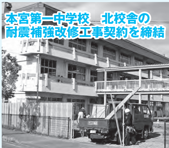
▲耐震補強工事が始まる本宮第一中学校北校舎
