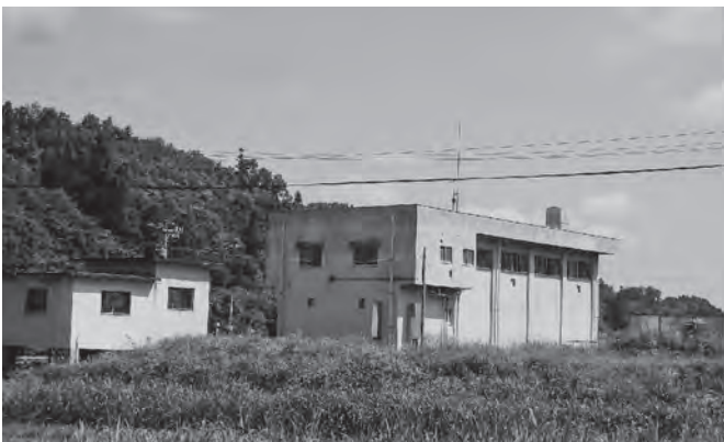
安達疏水土地改良区ポンプ場（和田字南大沢地内）
