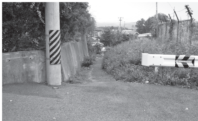
復興住宅建設に伴い拡幅予定の道路 (吹上から兼谷平へ抜ける市道)
