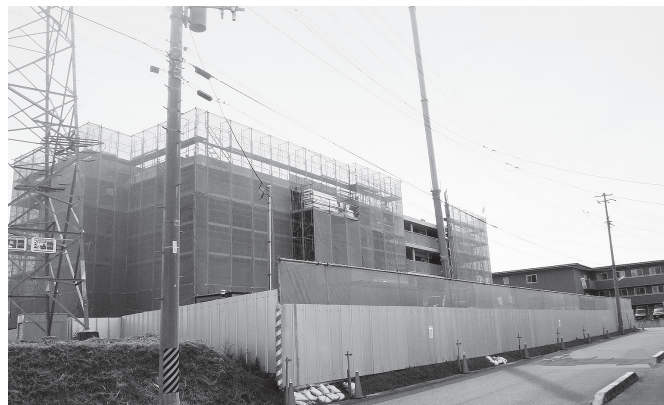
郡山市日和田町に建設中の復興公営住宅
