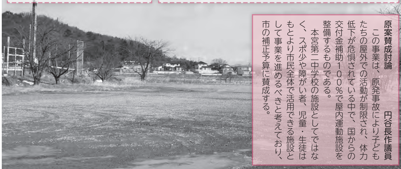
屋内運動施設建設予定地(神座グラウンド駐車場)
