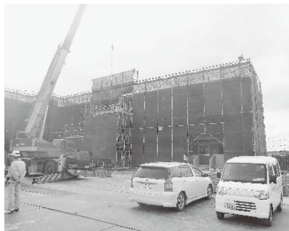
▲復興公営住宅工事箇所（仁井田字吹上地内）
