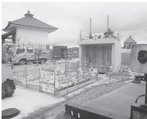
▲太郎丸排水ポンプ場工事箇所（本宮字太郎丸地内）
