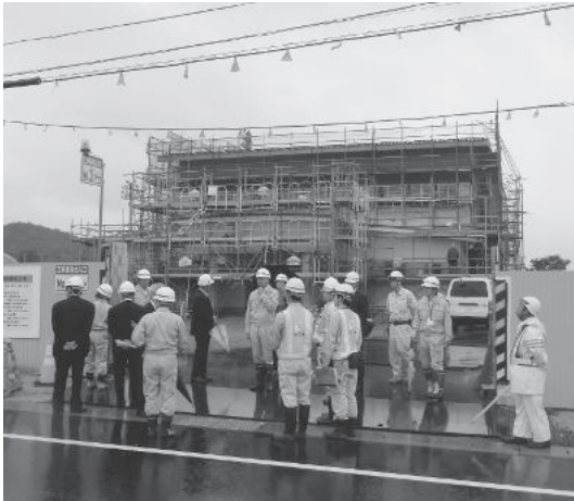
▲屋内運動施設建設工事現場（関下字東原地内）
