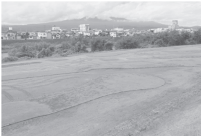
▲現在工事中のコミュニティ交流広場
