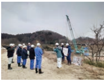
▲五百川橋架替工事箇所
