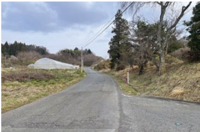
▲一日も早い早期完了を（一斗内・赤坂線 長屋工区）
