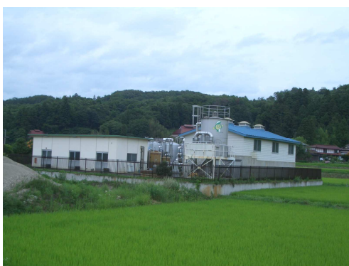
東禅寺浄水場
