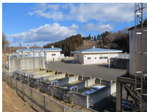
平田石浄水場
