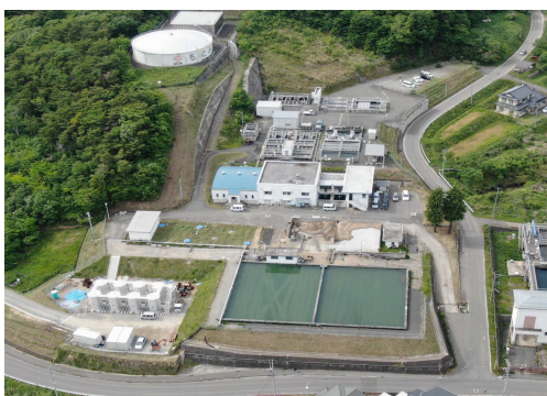
立石山浄水場
