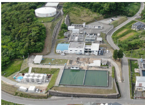
立石山浄水場
