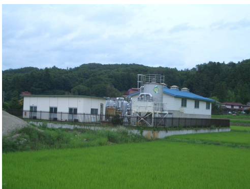
東禅寺浄水場
