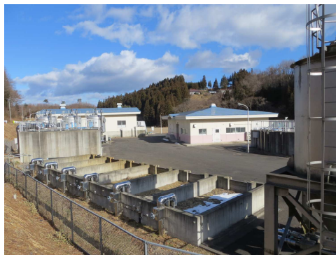
平田石浄水場
