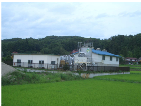
東禅寺浄水場
