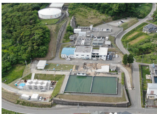
立石山浄水場
