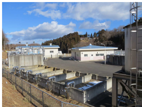
平田石浄水場
