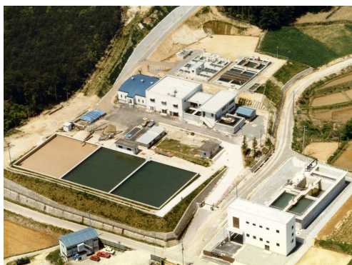
立石山浄水場
