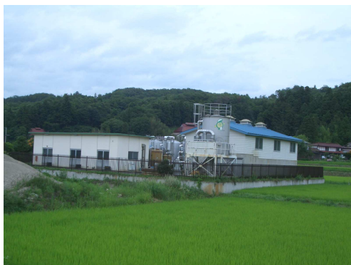
東禅寺浄水場
