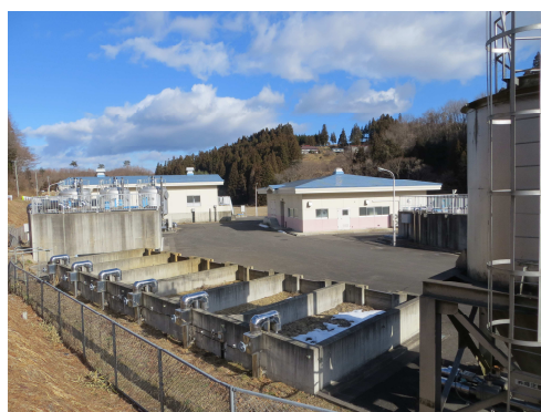
平田石浄水場
