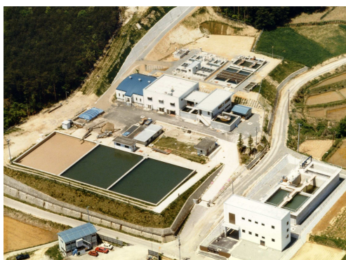
立石山浄水場
