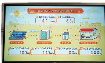
1階入口に設置している太陽光発電モニターでは、発電・蓄電状況などを確認できます。
